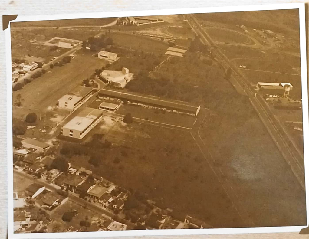
Área do "Campus" com seus primeiros prédios.
