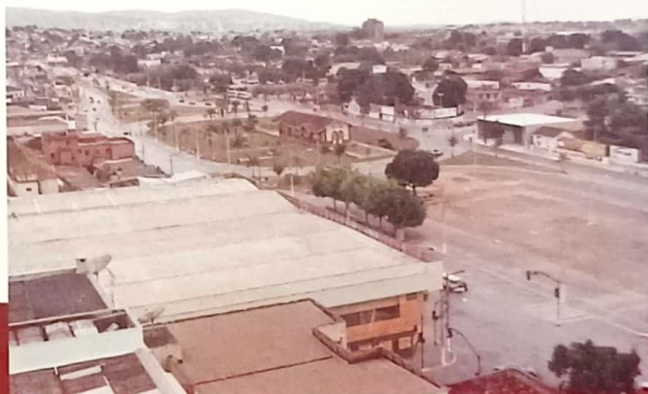
Visão geral da área. Museu Ferroviário
