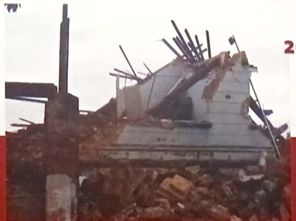
Destruída em janeiro de 2006
